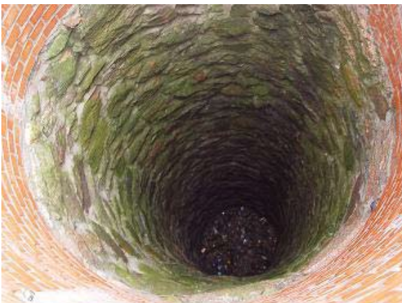
Le fond du puits dans la cour d'entrée
